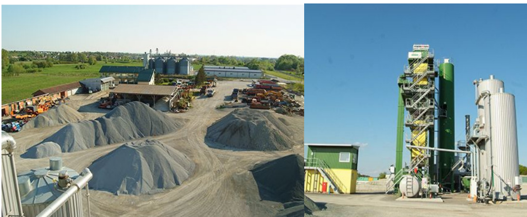
Slika 4. Asfaltna baza i RD za građevni otpad tvrtke Poduzeće za ceste d.o.o. Bjelovar
