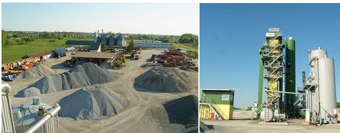
Slika 4. Asfaltna baza i RD za građevni otpad tvrtke Poduzeće za ceste d.o.o. Bjelovar
